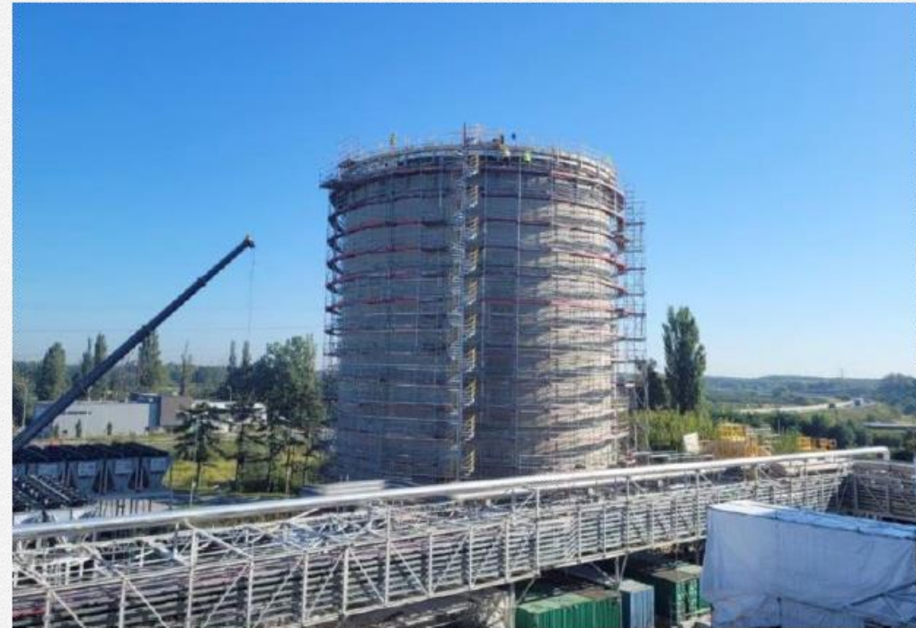
Magazyn ciepła Na terenie EC Czechnica-2 (fot. PGE Energia Ciepła)
